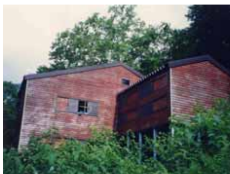
冬山前進基地 (S44竣工)
